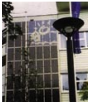
Moduli fotovoltaici come rivestimento di un edificio
