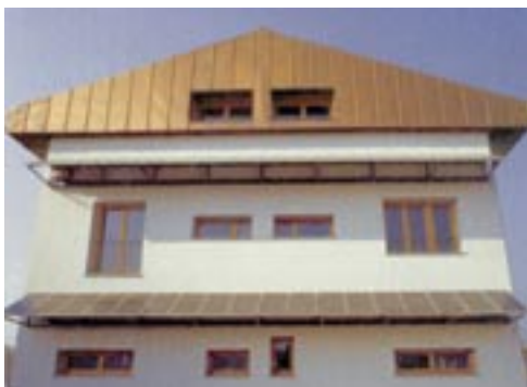
Moduli fotovoltaici come frangisole
