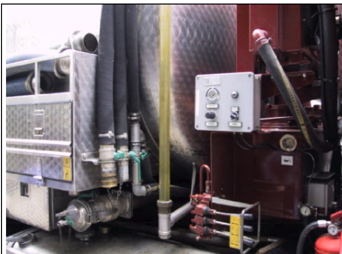
MODELLO SP/2/FP/N INSTALLATO SU ATTREZZATURA SPURGO POZZO NERO
